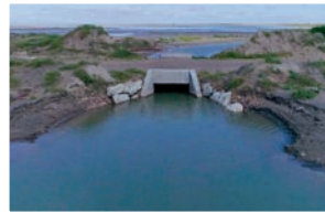
1 Vanne d'entrée d'eau réhabilitée
