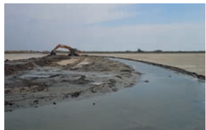
3 Curage d'un canal
